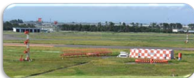
【 NAV局舎及び訓練施設 】
