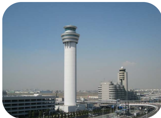
● 東京国際空港 管制塔
