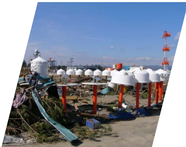
●津波により破壊されたVOR空中線
