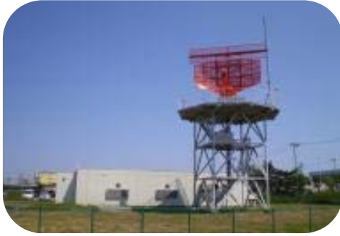
●レーダー実習局舎
