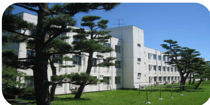
● 研修生寮(AB棟)外観
