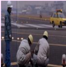
灯火の交換作業
