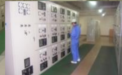
電気施設の日常点検
