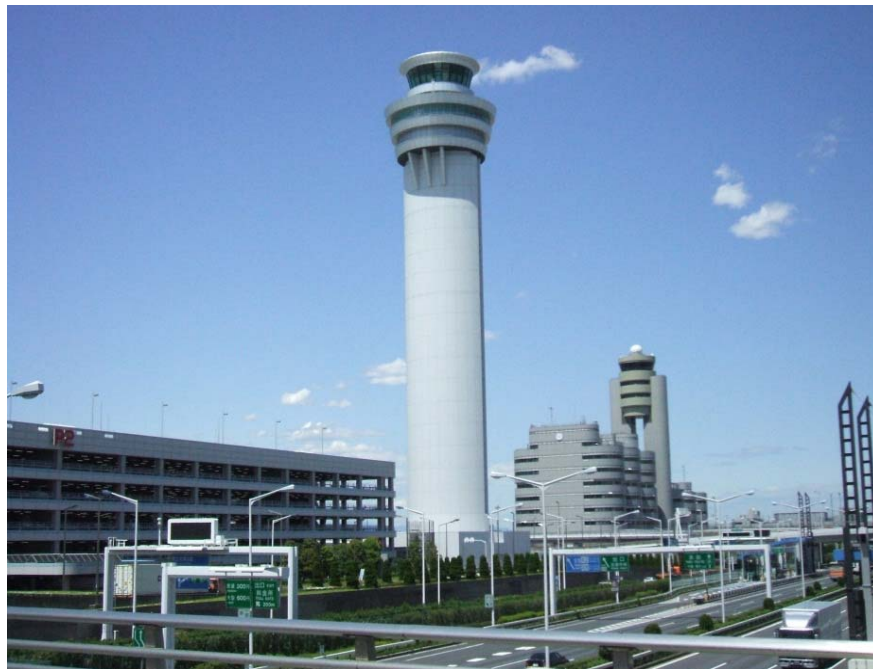
RC造、地上約116m（世界3位） 中間階免震及び制振装置（風対策）を採用
