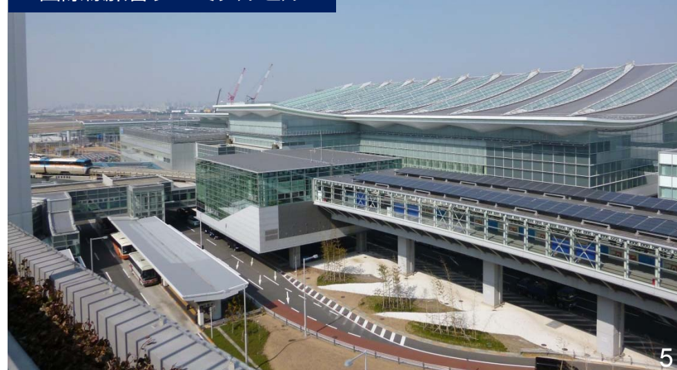
国際線旅客ターミナルビル
