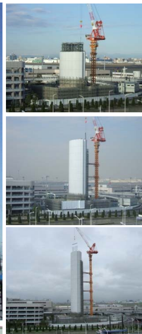
RC造、地上約116m（世界3位） 中間階免震及び制振装置（風対策）を採用
