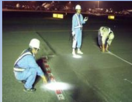
補修の範囲を測定
