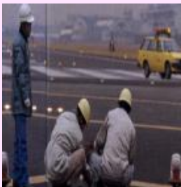
灯火の交換作業
