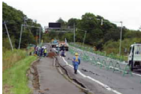
平成15年十勝沖地震による被害状況(一般国道38号/音別町)
