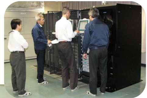
●FACE専門研修 FACE運転実習
