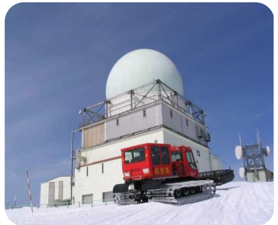
● 横津岳 航空路監視レーダー
