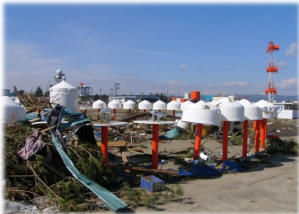
●津波により破壊されたVOR空中線
