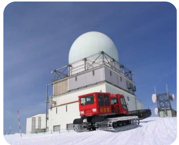
● 横津岳 航空路監視レーダー
