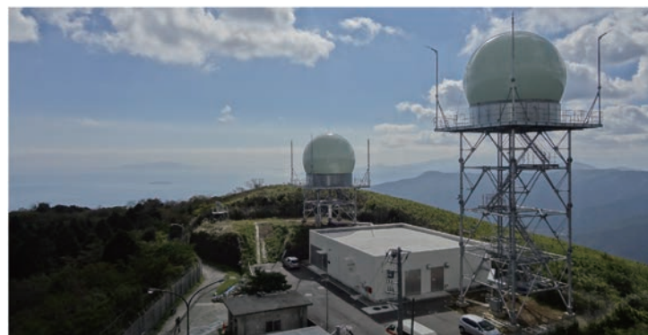
航空路監視レーダー 日本中の航空路（空の道）を監視するレーダー
