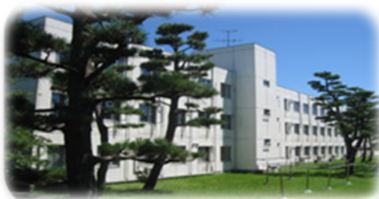
【研修生寮 A・B 棟】
