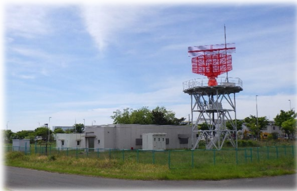
【レーダー局舎】
