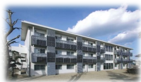
【研修生寮 D 棟】
