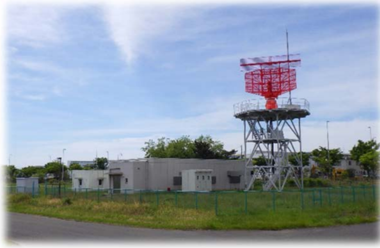
【レーダー局舎】
