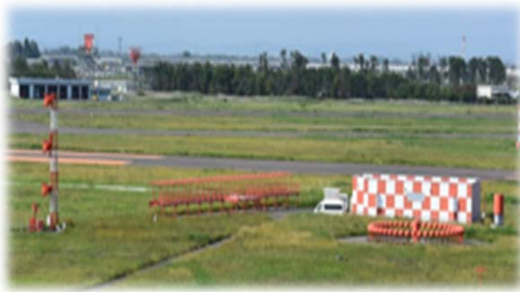
【NAV 局舎及び訓練施設】
