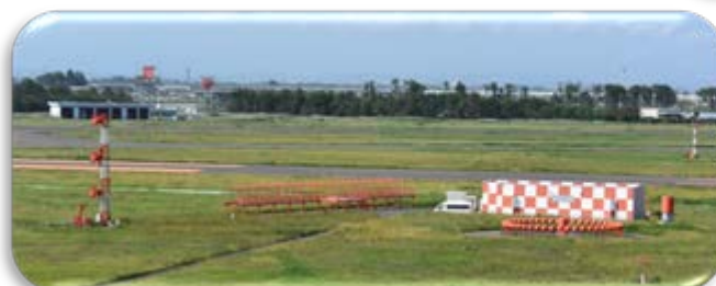
【NAV局舎及び訓練施設】
