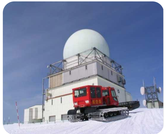
● 横津岳 航空路監視レーダー
