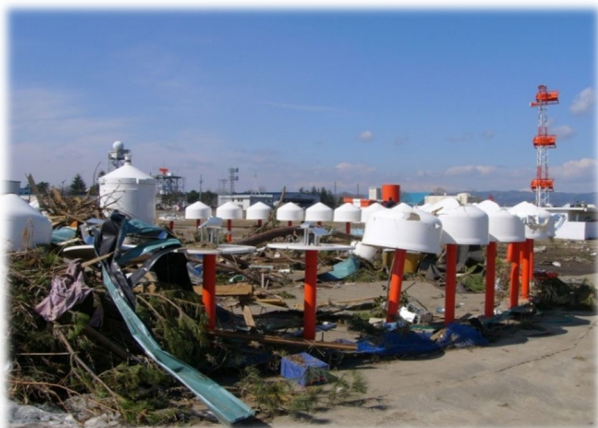
●津波により破壊されたVOR空中線
