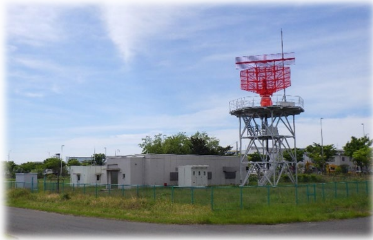
【レーダー局舎】
