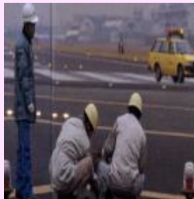
灯火の交換作業
