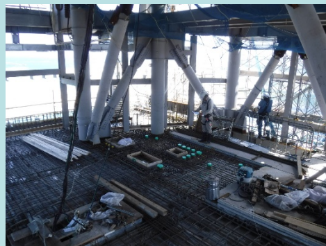
管制塔 (施工状況)
