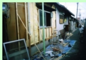
住宅の防音工事
