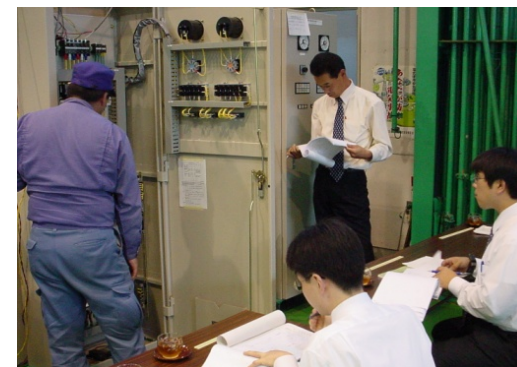
空気調和設備の検査風景
