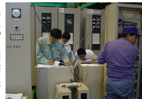
UPSの検査風景
