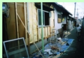
住宅の防音工事
