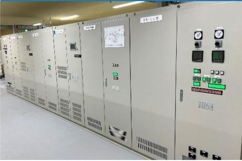
無停電電源設備にはバッテリーが搭載されており、停電時においても常時安定した電力を供給することができる。
