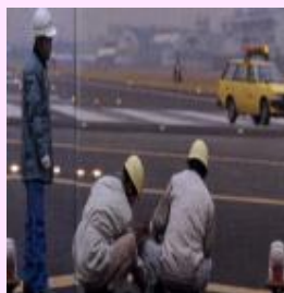
灯火の交換作業
