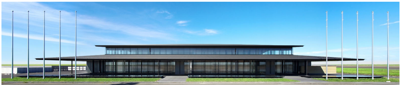
貴賓室整備事例
