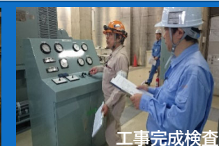
工事完成検査
