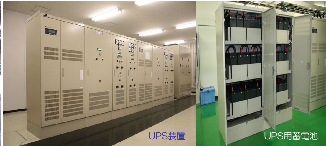
無停電電源設備
