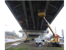
高所作業車による洗浄イメージ
