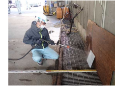
ヤード試験状況
