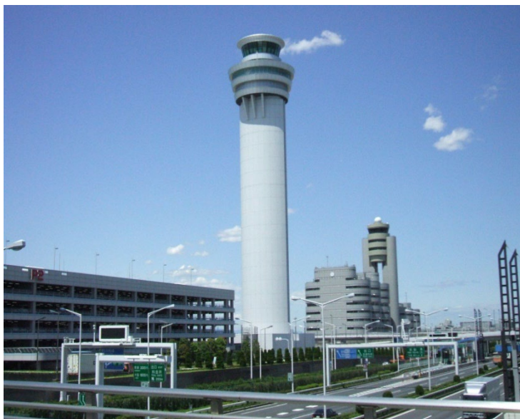
管制塔整備事例
