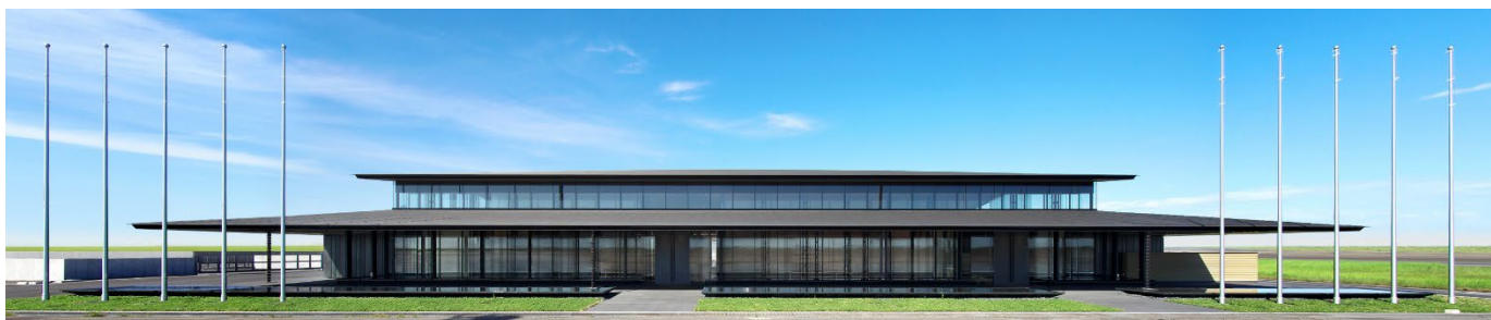
貴賓室整備事例
