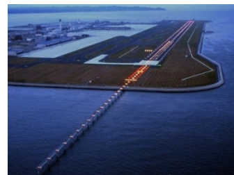
進入灯橋梁・航空灯火
