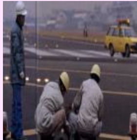
灯火の交換作業
