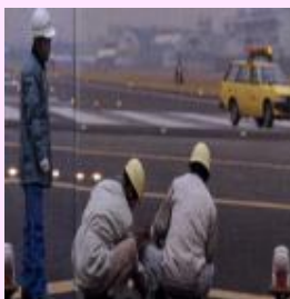
灯火の交換作業
