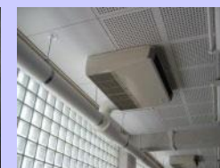
学校等の防音工事 (防音サッシ、空調機設置)
