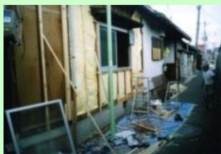
住宅の防音工事
