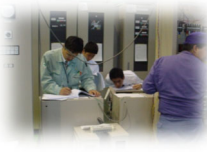
動力制御盤の工場検査
