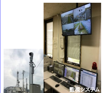
監視システム
