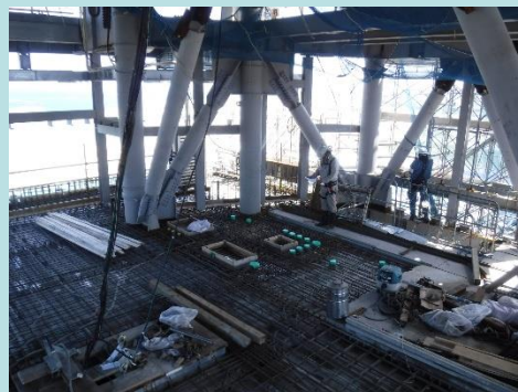
管制塔 (施工状況)
