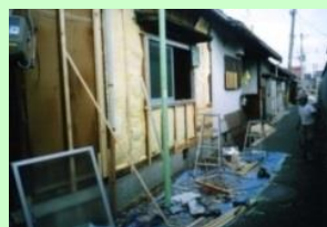
住宅の防音工事
