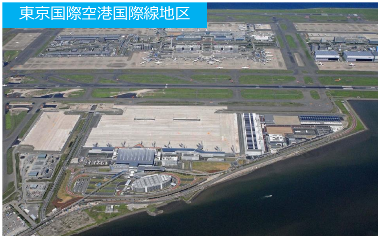
国際線旅客ターミナルビル
