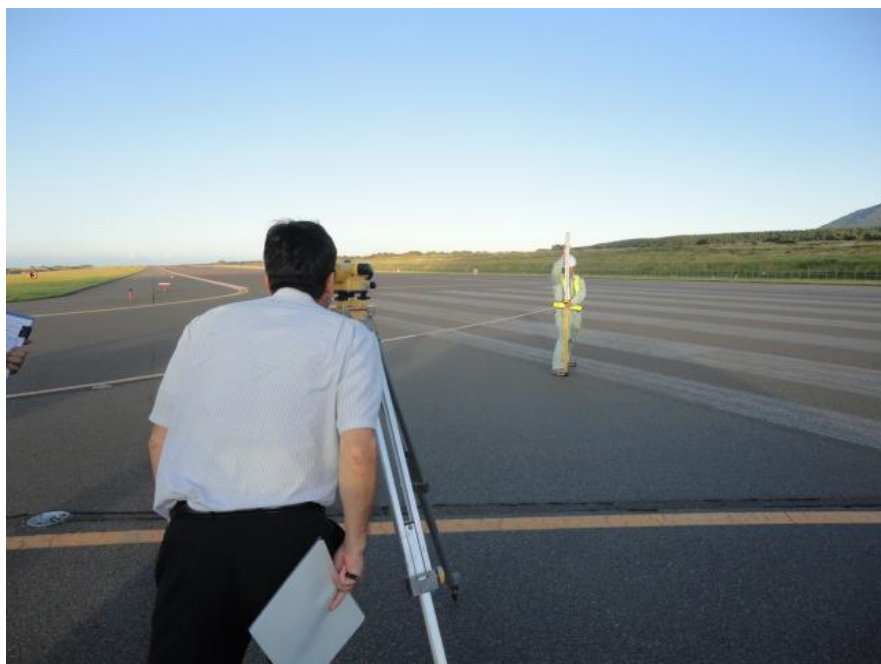
航空法に基づく滑走路の勾配を満たしているか監査している様子 （利尻空港（北海道））
