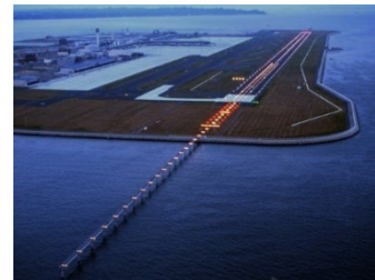
進入灯橋梁・航空灯火
