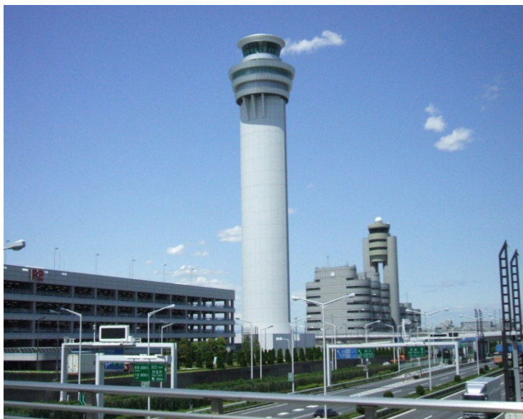
管制塔整備事例
