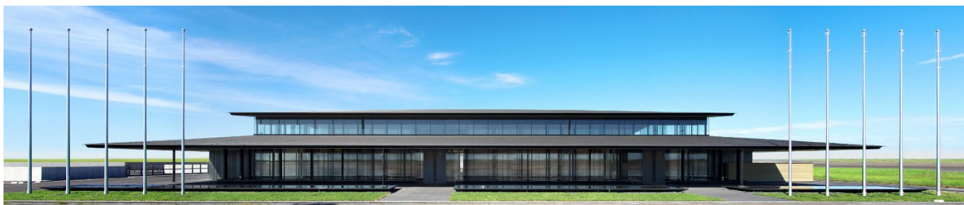
貴賓室整備事例
