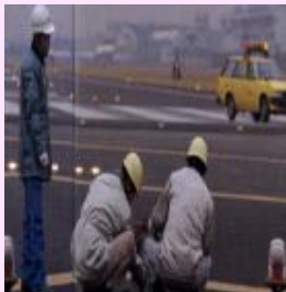
灯火の交換作業
