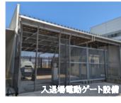
入退場電動ゲート設備
