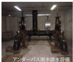
アンダーパス雨水排水設備
