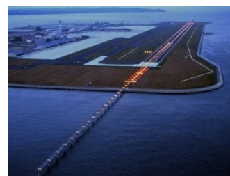
進入灯橋梁・航空灯火
