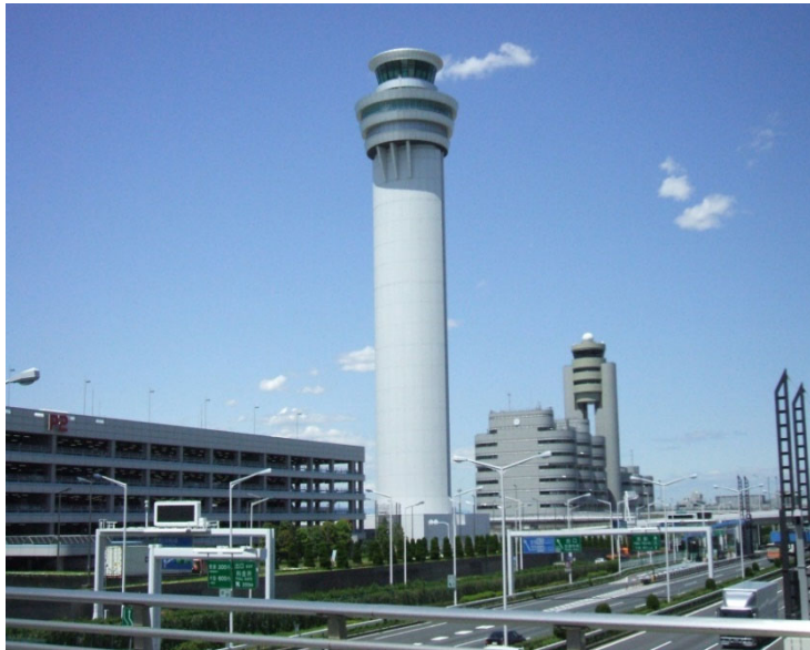
管制塔整備事例
