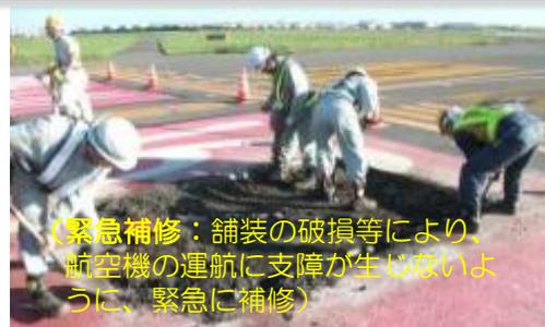
（緊急補修：舗装の破損等により、航空機の運航に支障が生じないように、緊急に補修）
