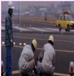
灯火の交換作業
