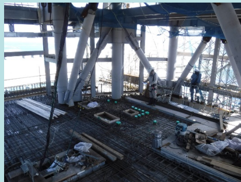
管制塔 (施工状況)
