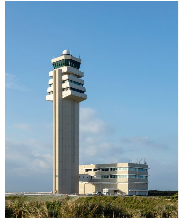
R C造 地上約90m (竣工R1.10)
