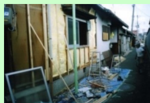
住宅の防音工事
