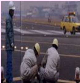
灯火の交換作業
