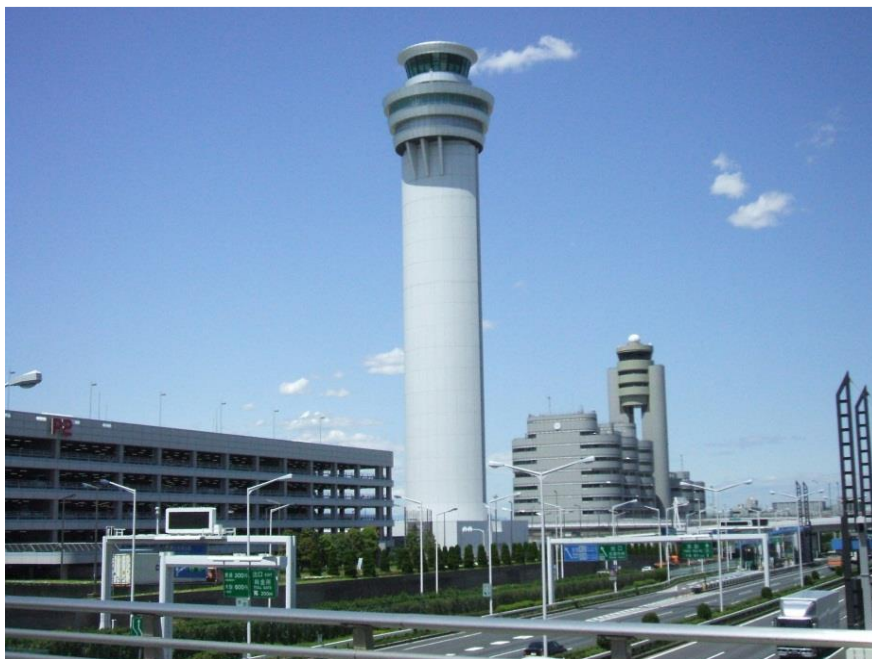
RC造 (一部S造) 高さ地上約116m (世界3位)
