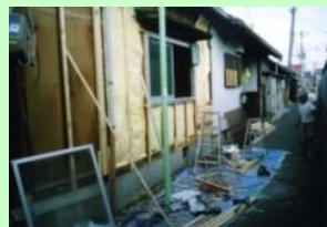
住宅の防音工事
