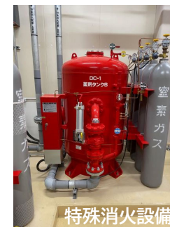
消火ポンプ設備
