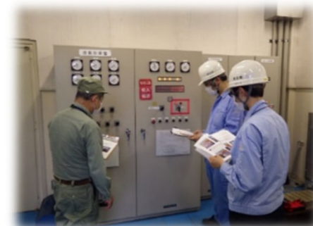
空港運用終了後に実施する機械設備点検業務（停電作業）の立会い
