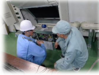
工事監督（試験立会い）
