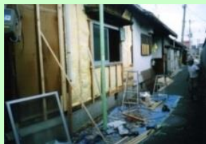
住宅の防音工事
