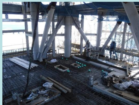
管制塔 (施工状況)
