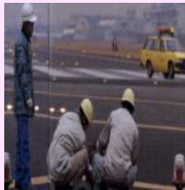
灯火の交換作業
