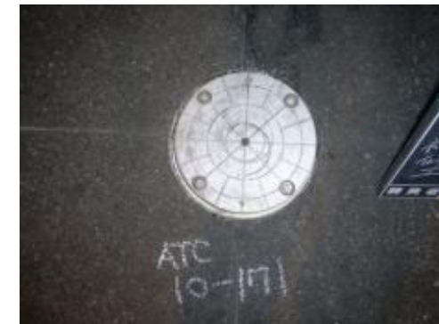
航空灯火施設撤去完了の様子
