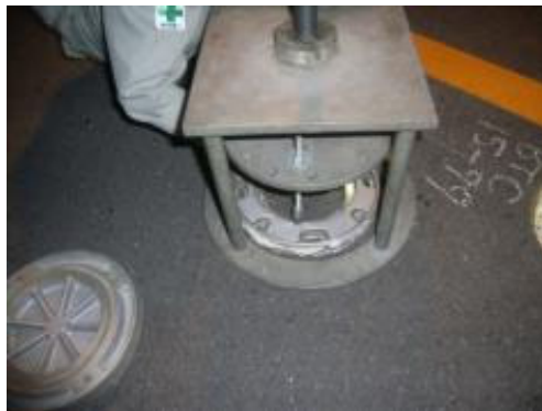
航空灯火施設の撤去の様子
