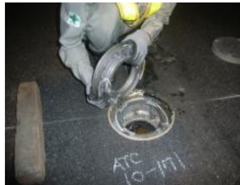
航空灯火施設の撤去の様子
