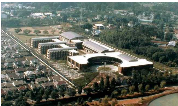
国土交通大学校 柏研修センター（千葉県柏市）
