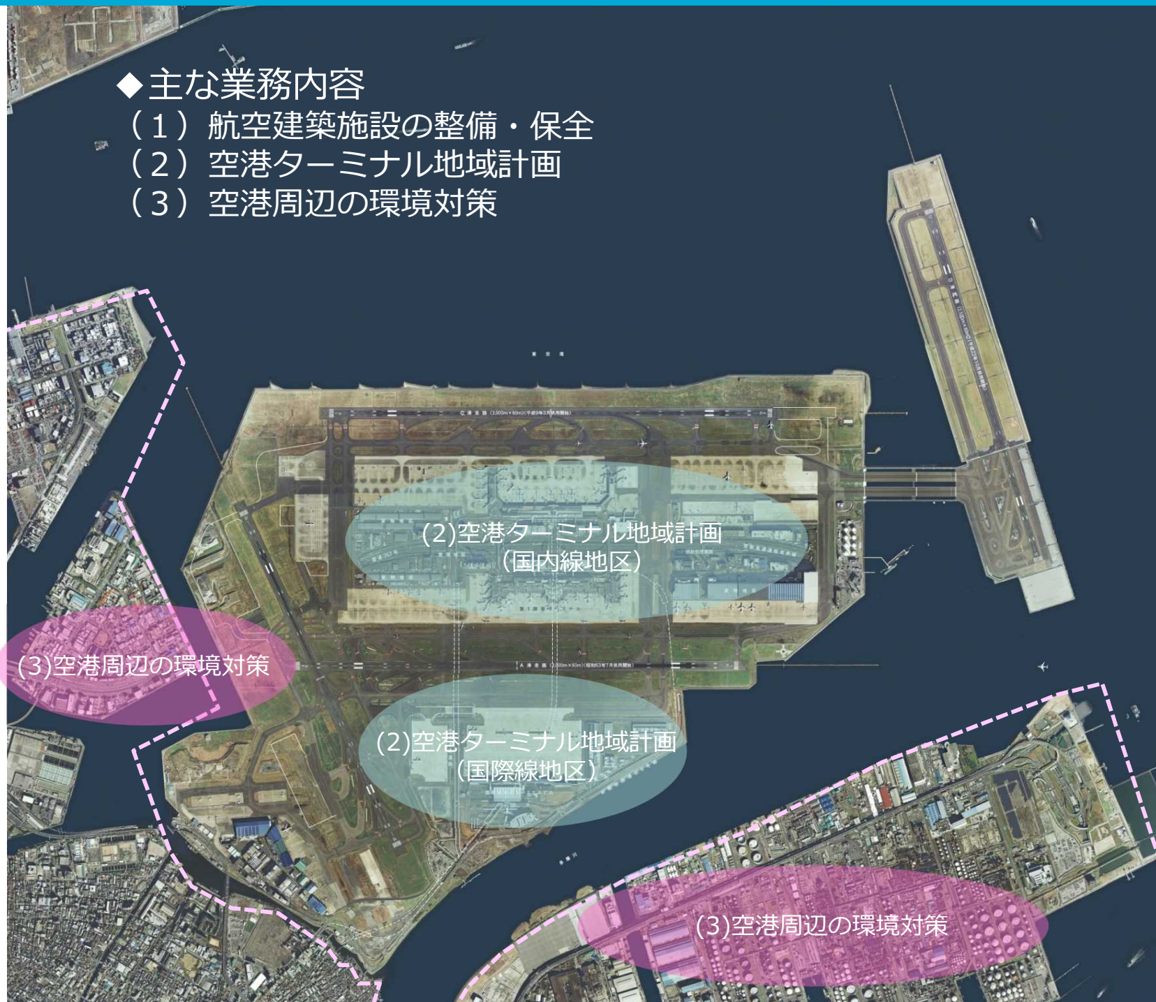
(1) 航空建築施設の整備・保全
