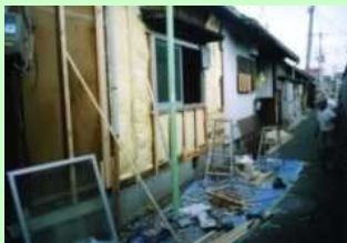
住宅の防音工事
