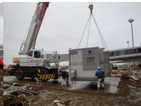
可搬形発電設備を設置
