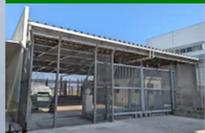
制限区域への出入りを管理する電動ゲート
