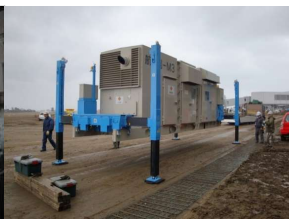
可搬形発電設備を設置
