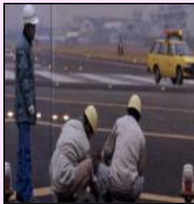
灯火の交換作業
