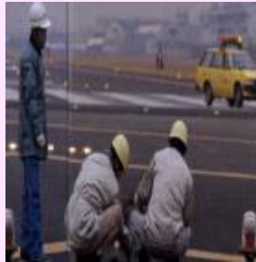
灯火の交換作業
